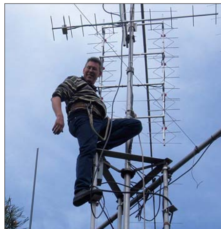
DF1JM bei Arbeiten am Mast
